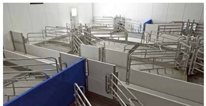
Salle d'accouchement avant la pose des grilles.
