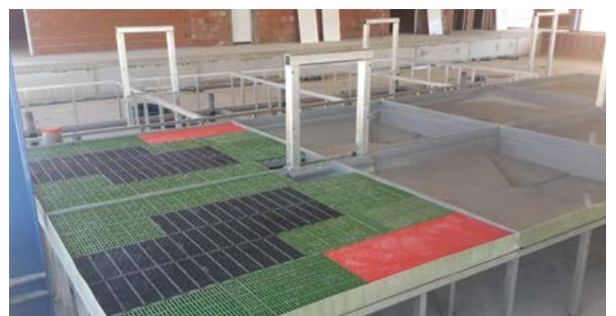
L'espace libre sous les bacs permet de faire passer la tuyauterie et les câbles.
